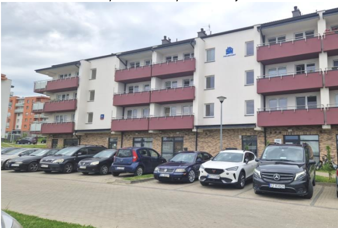
Budynek od strony wschodniej
